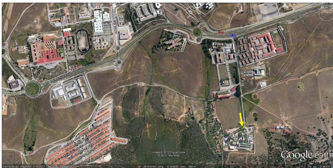
Imagen 1: Situación ETAP acceso por glorieta junto Residencia Asistida y Centro Penitenciario.
