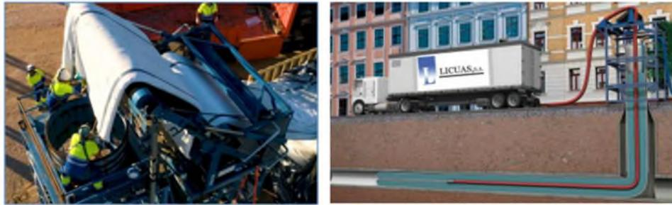
**Reversión con aire y curado con vapor de agua:** El encamisado se realiza utilizando un tambor de reversión con aire a presión, que hace avanzar la manga a través de la canalización, y la posterior introducción de vapor de agua para la polimerización de la resina.
